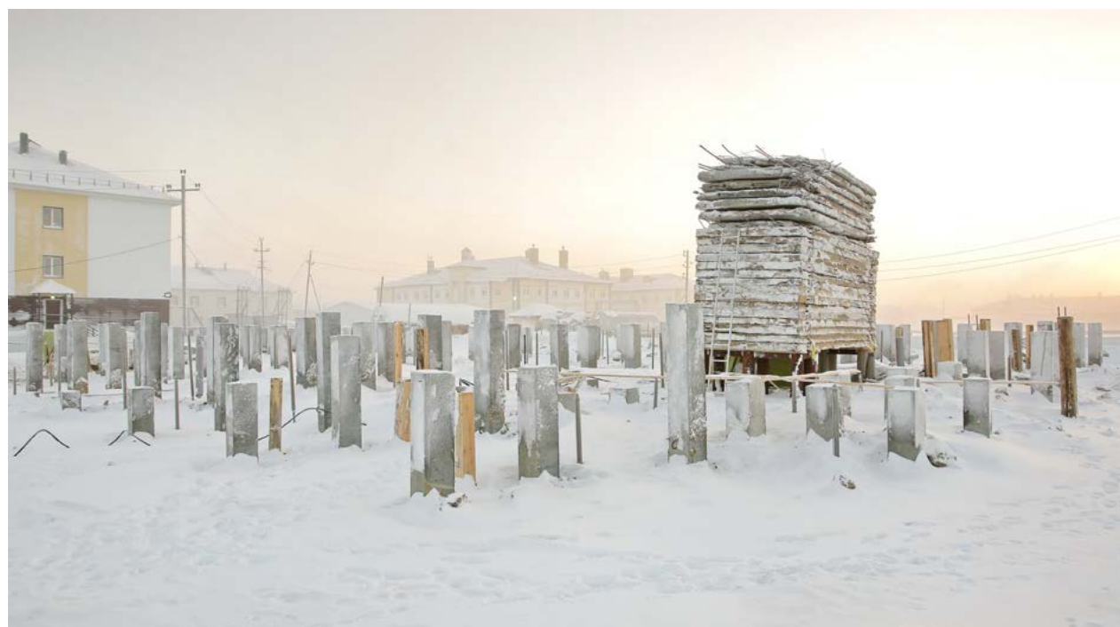
На стройплощадке педиатрического отделения в Тазовском проводится испытание свай
