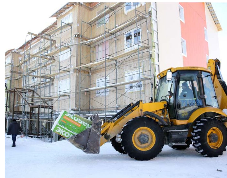
В этом году компания «Спецстройинвест» планирует сдать два дома по улице Новой
