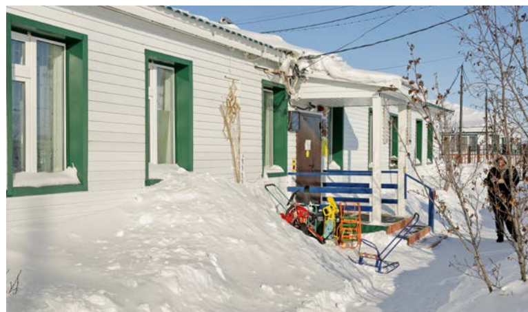
Первый корпус детского сада «Белый медвежонок» в этом году ожидает капитальный ремонт
