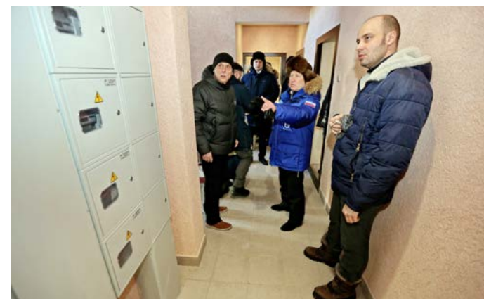
Строители показывают Василию Паршакову приборы учёта, которые для удобства разместили в щитовых на лестничных площадках
