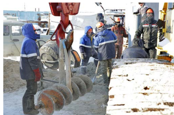
На стройплощадке ВОС-500 работают 16 человек и 6 единиц техники, к концу марта свайные основания должны быть готовы
