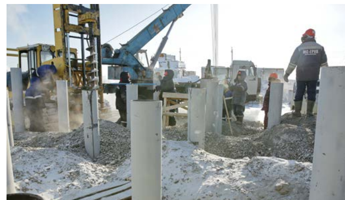
Компания «Тазстройэнерго» занимается подготовкой свайного основания под новую станцию очистки воды на 500 кубов и две ёмкости по 350 кубов каждая
