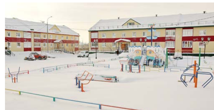
Уличные тренажёры на площадке в микрорайоне Геолог демонтируют
