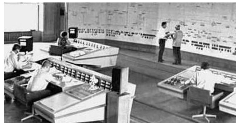
Центральный диспетчерский пульт управления Единой энергетической системой СССР
