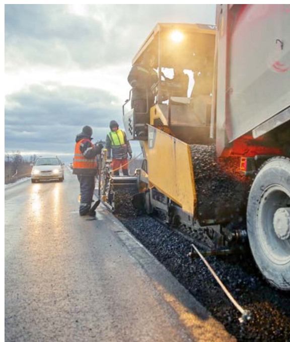
Крупно-зернистый асфальтобетон укладывается первым слоем на сухую поверхность или после прогрунтовки
