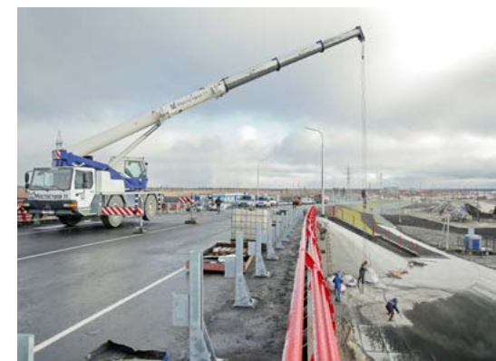
За неделю до сдачи моста строители устанавливали барьерные ограждения
