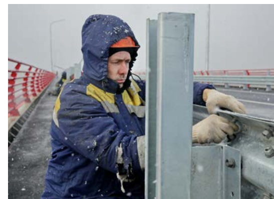
За неделю до сдачи моста строители устанавливали барьерные ограждения
