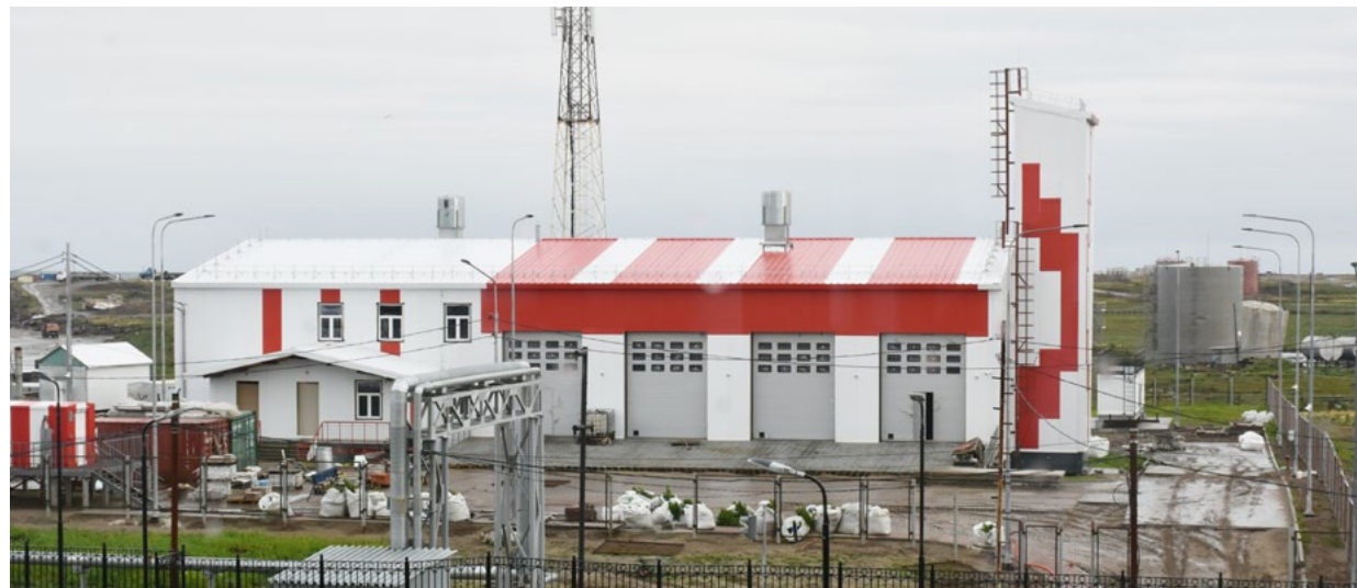
Здание пожарного депо оборудовано газодымовой камерой для тренировок личного состава
