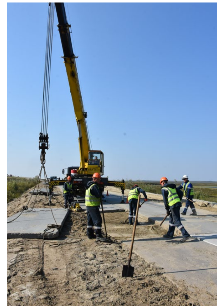
Бригада рабочих компании «РегионСпецТранс» перекладывает плиты на участке дороги от Газ-Сале до развилки на Тазовский. Завершить работы они планируют к концу сентября
