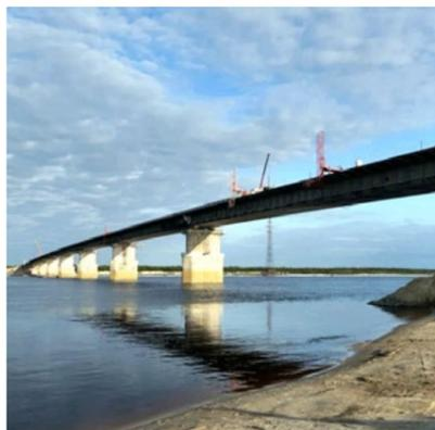
На строительной площадке моста через реку Пур завершился один из ключевых этапов - соединены берега реки. Рабочие установили на опоры полностью собранное пролётное строение и заварили последний, так называемый "золотой" шов.
