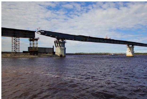
На эти работы ушло более 270 тысяч м<sup>3</sup> песка. Сейчас рабочие занимаются подготовкой щебёночного основания дорожного полотна. Эти работы завершены на 20%. Также ведутся работы по устройству конусов моста.
