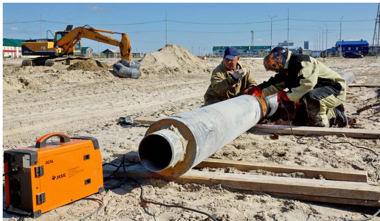
Специалисты компании «Сиб-Инвест-Строй» прокладывают сети тепло-водоснабжения для обеспечения второй и третьей очереди микрорайона Солнечный
