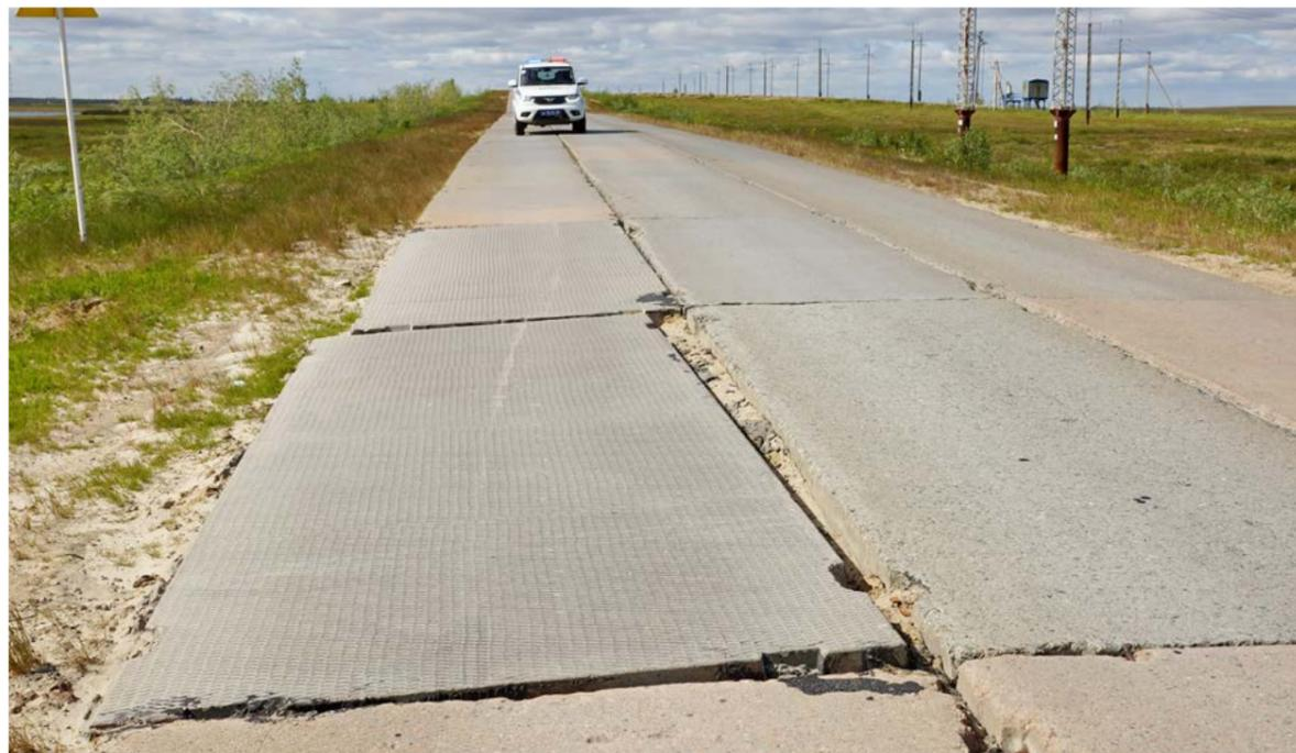
На 5-м километре дороги от перекрёстка до Газ-Сале на правой плите, которую положили в прошлом году, лопнула сварка
