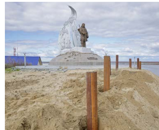
Вокруг памятника Ваули подрядчик уже сделал вертикальную планировку и забил сваи под смотровую площадку, ограждение и опоры освещения
