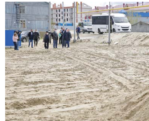
Вокруг памятника Ваули подрядчик уже сделал вертикальную планировку и забил сваи под смотровую площадку, ограждение и опоры освещения
