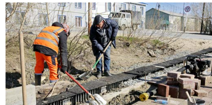
После зимы рабочие приводят в порядок систему водоотведения вдоль зоны отдыха неподалёку от дома Геофизиков, 18
