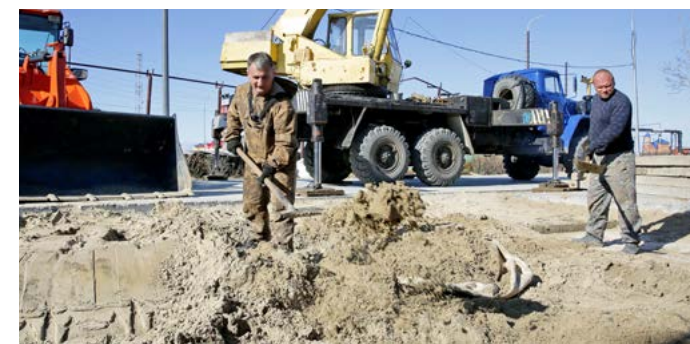
На улице Спортивной подрядчик - ООО «РИК» - занимается выравниванием дорожного полотна и обустройством съездов к жилым домам и зданиям
