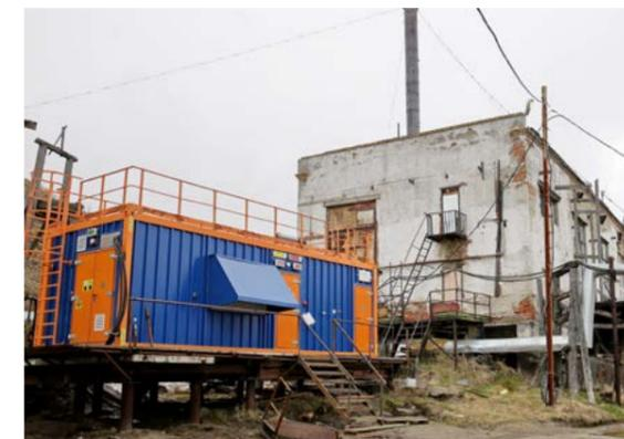
Мощность каждого из новых дизель-генераторов - 400 киловатт. По подсчётам специалистов, этого достаточно, чтобы бесперебойно обеспечивать небольшую Находку электроэнергией. При максимально низких температурах энергопотребление села составляет 420 киловатт в час.
