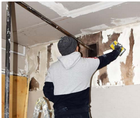
В доме № 32 по улице Пушкина работники «ТазСпецСервиса» завершают косметический ремонт первого подъезда, который пострадал в результате пожара
