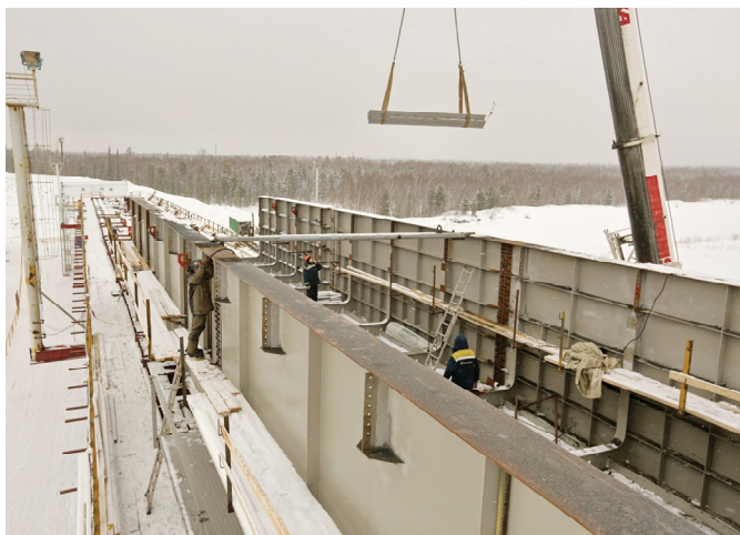
Работы по строительству транспортного объекта ведутся в круглосуточном режиме
