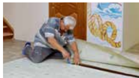
Ремонт близится к завершению
