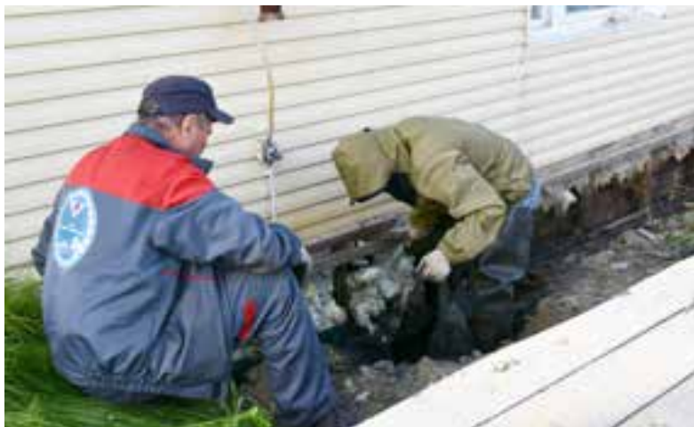
Рабочие «Тазспецсервиса» ремонтируют канализацию дома Геофизиков, 24
