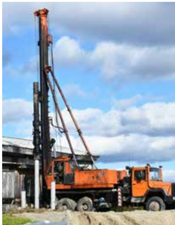
Строительство новой электростанции в Тазовском
