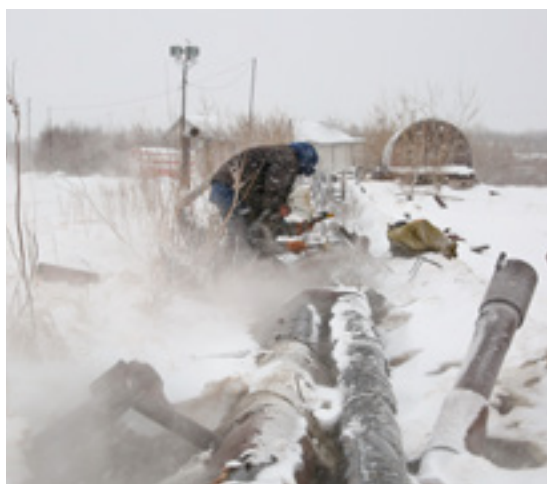
Работы по отпариванию трубы на водозаборе велись при любых погодных условиях
