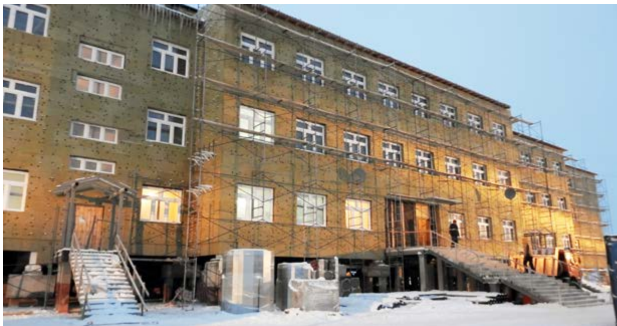
К середине декабря строители планируют закончить работы на фасаде здания школы на 720 мест в Гыде
