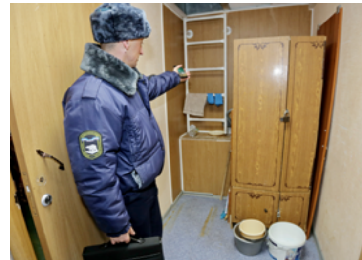
Александр Харитоненко отметил, что при пожаре пробраться к чердачному помещению по адресу: ул. Пушкина, 45, будет сложно - проход захламлён
