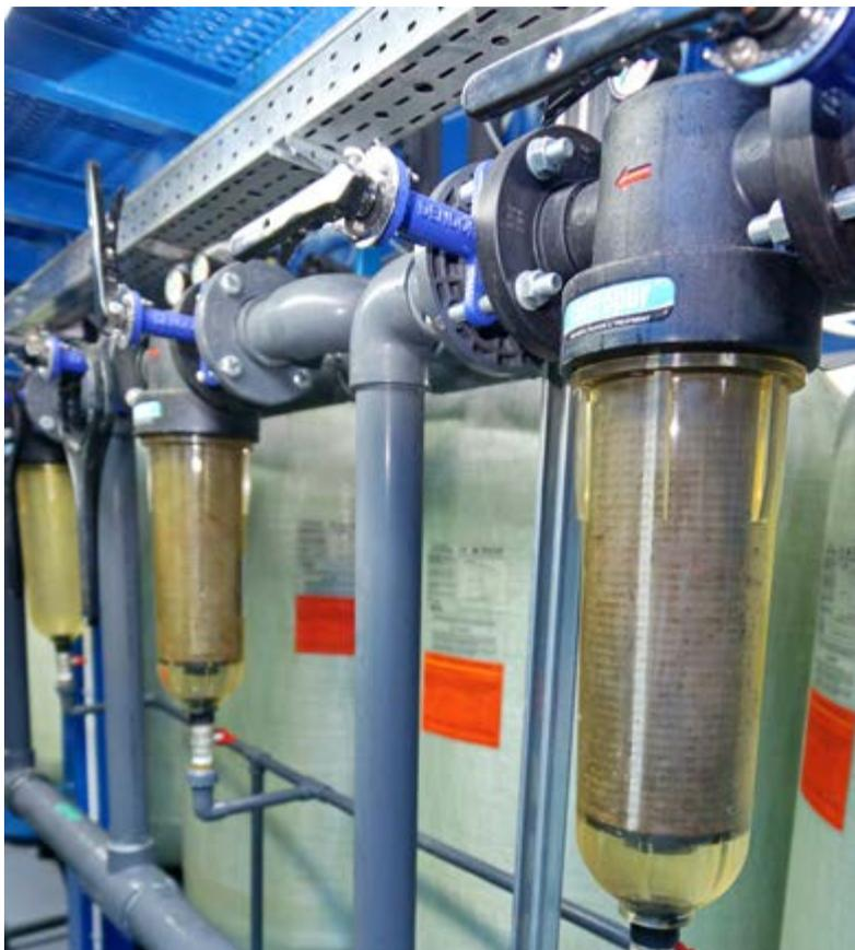
В этом году в Тазовском приобретены и смонтированы блочные водоочистные сооружения производительностью 1000 м<sup>3</sup>/сутки, которые сейчас находятся в режиме опытной эксплуатации
