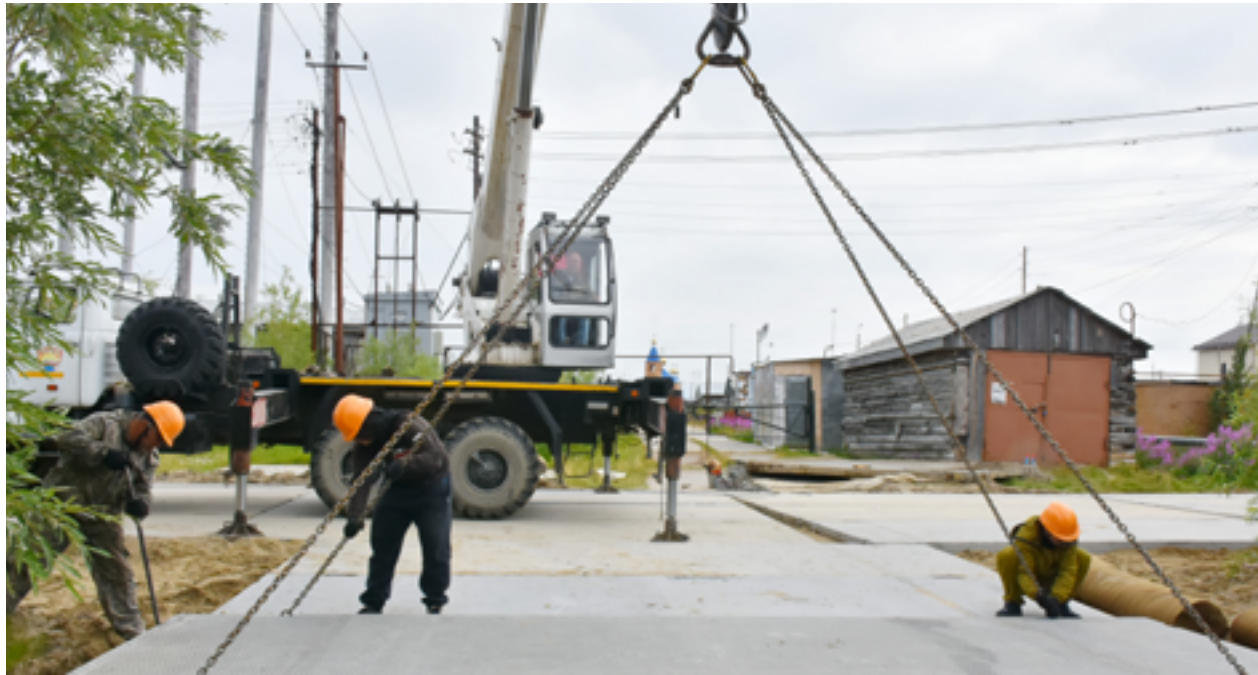
По улице Калинина в Тазовском между домами № 12 и 24 этим летом в рамках ремонтных работ уложили 308 новых плит
