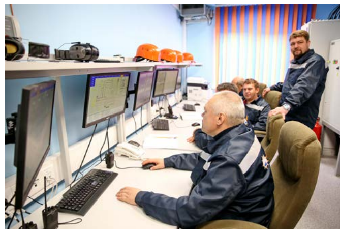
Автоматическая система управления ГПА-ТЭЦ № 1 позволяет своевременно выбирать наиболее эффективный режим работы в зависимости от нагрузки
