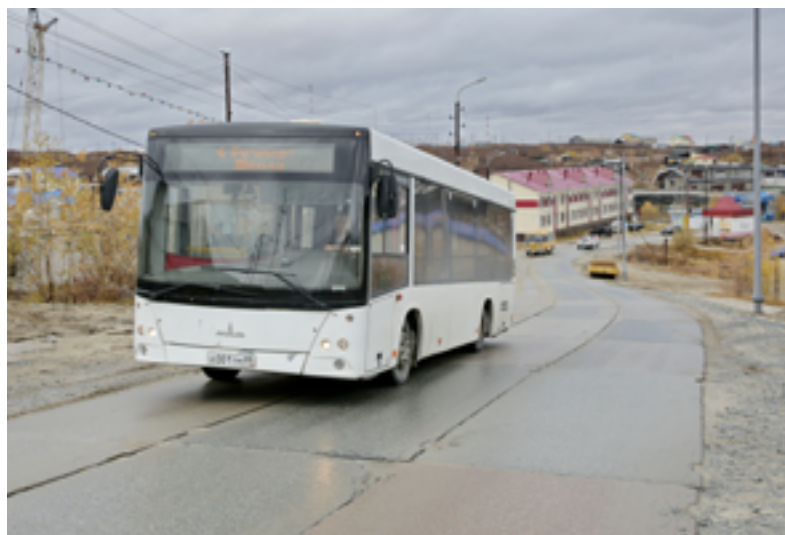
С 30 сентября в микрорайон Аэропорт будет закрыт проезд для всех видов транспорта - дорожники приступают к ремонту улицы Пристанской до дома № 41
