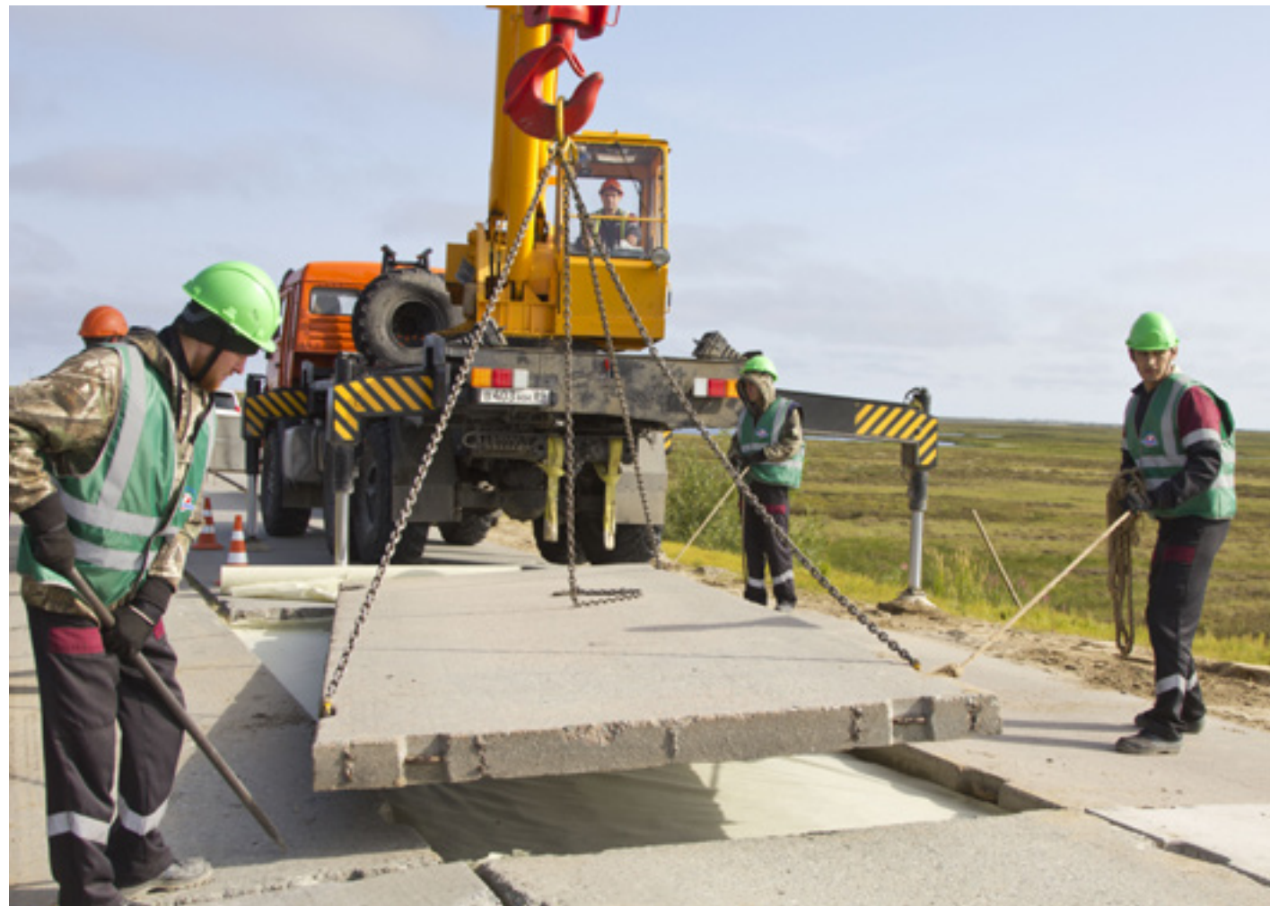
На 11-километровом участке дороги от Газ-Сале до перекрёстка планируется заменить 170 плит и переуложить порядка 600, а также отсыпать участки обочины песком
