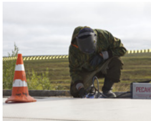
Все новые плиты обязательно сваривают между собой, также восстанавливают крепление на старых
