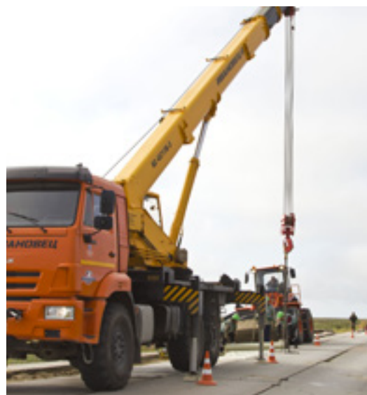
С середины июля рабочие восстанавливают дорожную одежду, перекладывают плиты, а дефектные заменяют на новые
