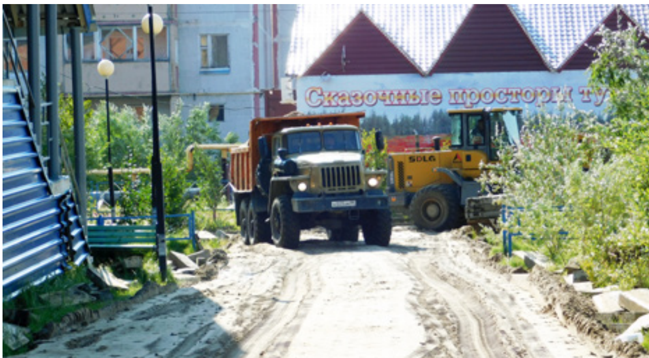
Работники общества «Кристалл» отсыплют основание для внутридворового проезда
