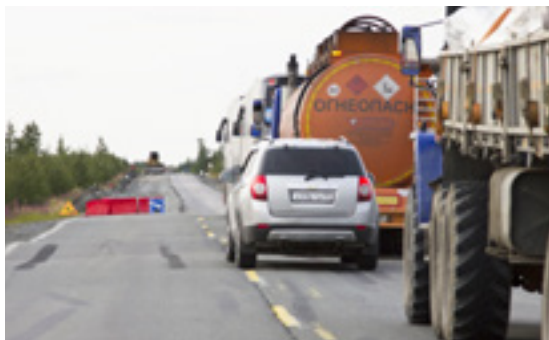
Движение на ремонтируемом участке дороги регулируется светофором
