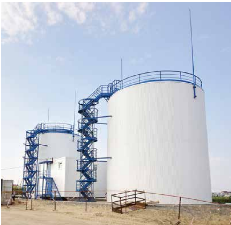
В Тазовском запущена в работу станция по очистке воды, производительностью 1000 кубометров в сутки
