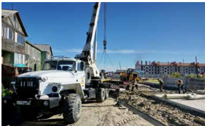
Тазовские дорожники ремонтируют проезд к новостройкам
