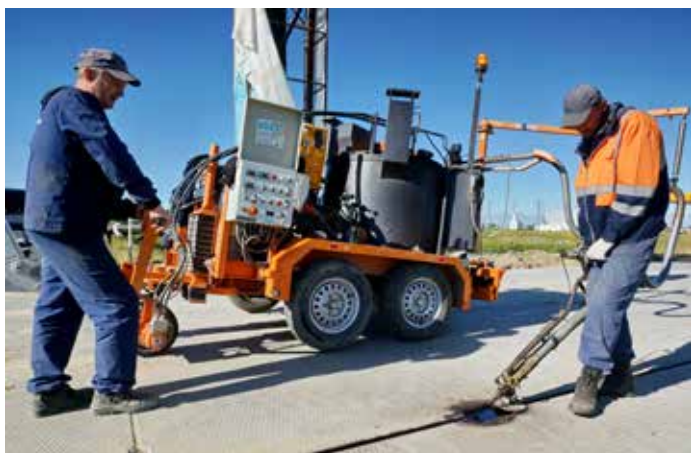
Работники «Реском-Тюмень» заливают швы
