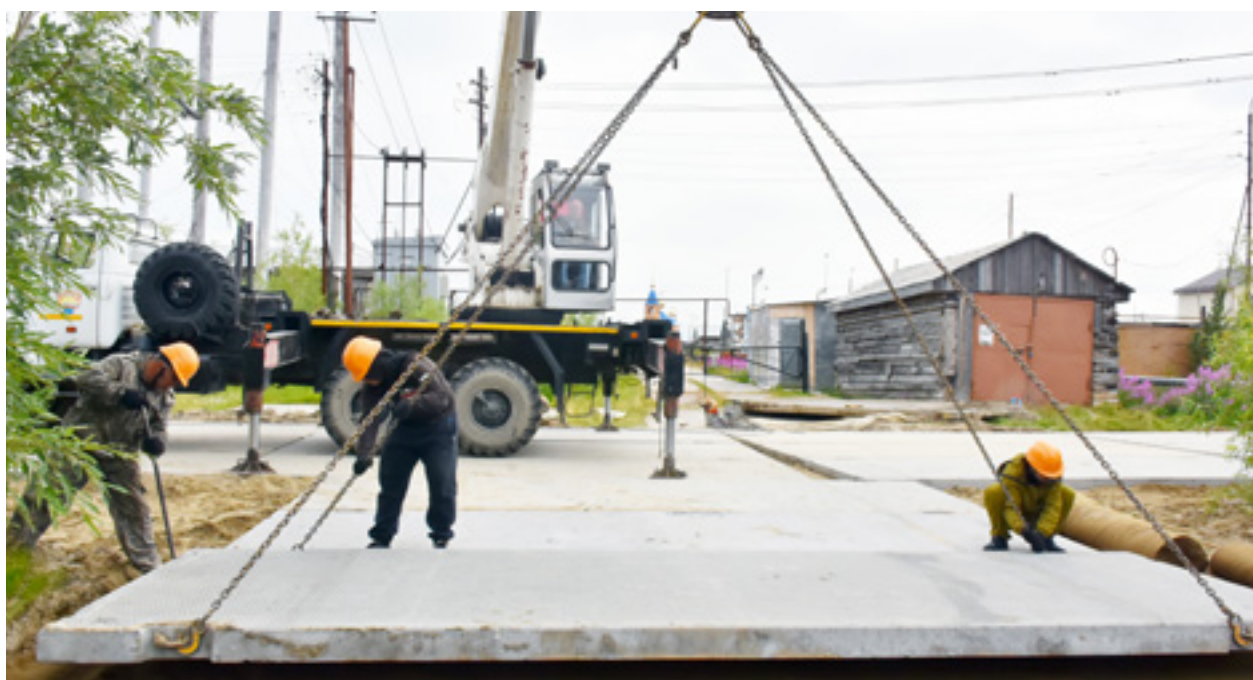
Бригада дорожников перекладывает съезд около дома № 24 по улице Калинина в рамках текущего ремонта участка дороги
