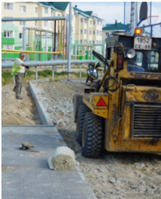
Рабочие ровняют песча- но-щебё- ночную смесь на площадке по периме- тру откры- того хок- кейного корта для укладки брусчатки
