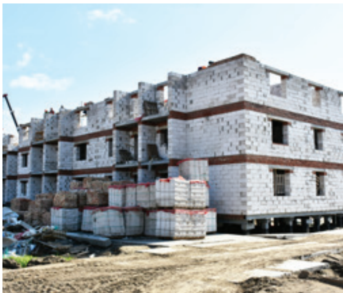
Строители обещают сдать в эксплуатацию жилые дома раньше намеченного срока
