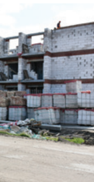
В Гыде продолжается строительство многоквартирных жилых домов
