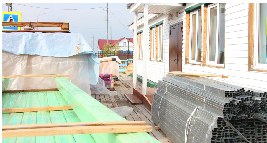
Ремонтные работы во втором корпусе строители планируют закончить к сентябрю
