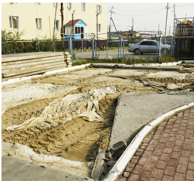
Подрядная организация уже приступила к перекладке дорожных плит во дворе детсада
