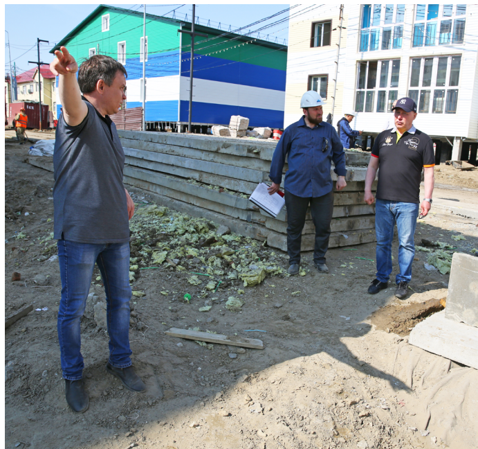
Возле строящихся домов по улице Советская в Гыде в рамках благоустройства создадут зону отдыха
