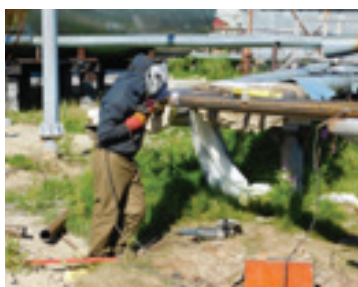
Последние швы - и новая тепло-трасса готова
