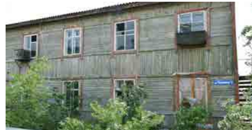
С начала года в районном центре снесли три аварийных дома. Следующий на очереди - Пушкина, 6. 15 семей уже расселили, здание обесточено и отключено от коммуникаций
