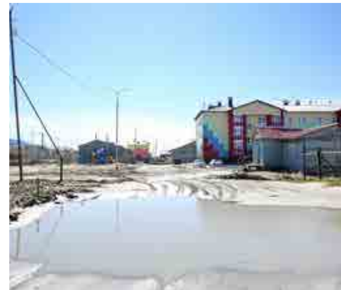
Микрорайон Геофизиков: сейчас здесь разливается огромная лужа, а к концу августа по проекту должен быть внутридворовой проезд из дорожных плит
