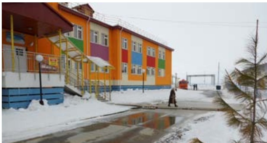
С 18 июня в детском саду «Радуга» начнут проводить ремонтные работы
