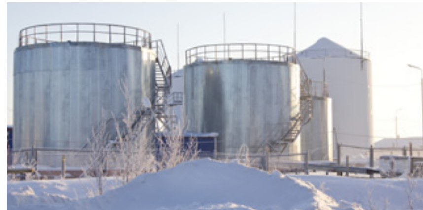
Строительство водоочистных мощностью 1000 кубов в сутки началось в прошлом году. После их запуска чистой водой будут обеспечены все жители села
