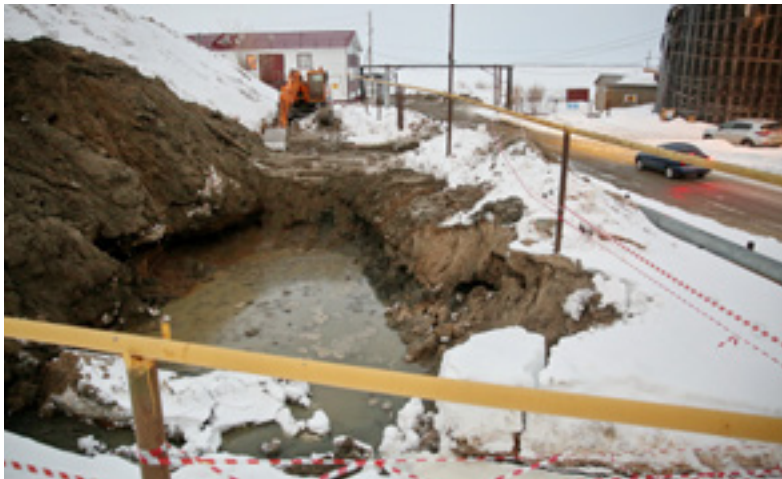
Подрядчик - общество «Кристалл» - роет котлован, в который будут собираться грунтовые воды
