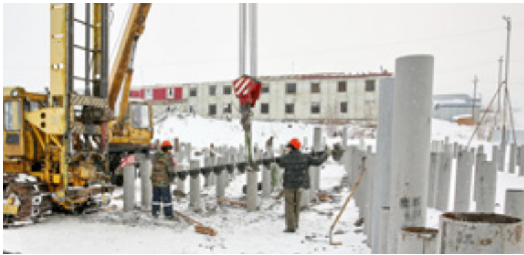
Компания «Тазстрой-энерго» завершает работы по бурению свай в основание 31-квартирного жилого дома
