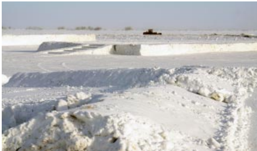
На реке Таз завершается строительство площадки для проведения Слета оленеводов
