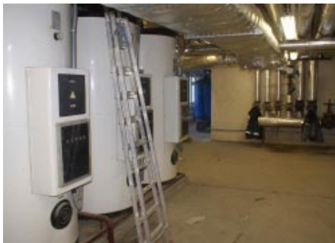
Локальные очистные детского сада
