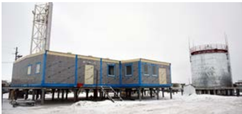
Новая котельная построена в микрорайоне Глубокое
