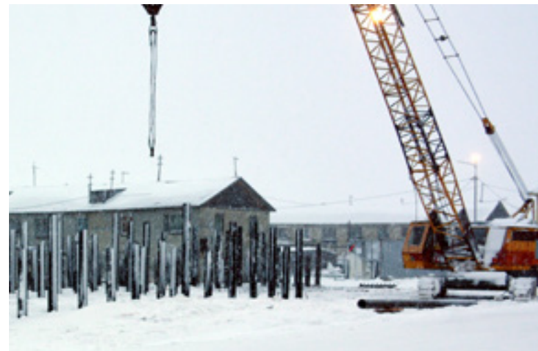
Свайное поле будущего дома в селе Антипюта, в котором будут предоставлены квартиры, в том числе и молодым семьям
